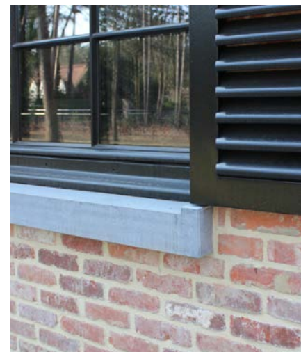
Pierre Bleue Belge - Dorpels en trappen (traptreden) worden altijd volvlak bevestigd met aangepaste mortel of natuursteenlijm
