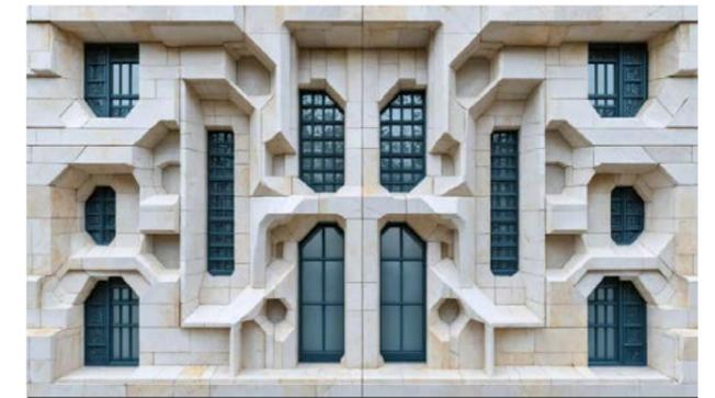
The Marble Guide - Élément de façade géométrique complexe en pierre réalisé à l'aide de l'impression 3D
