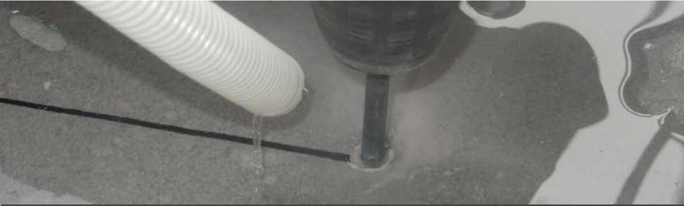
Uitvoering van een uitsparing door in elke hoek een gat te boren
