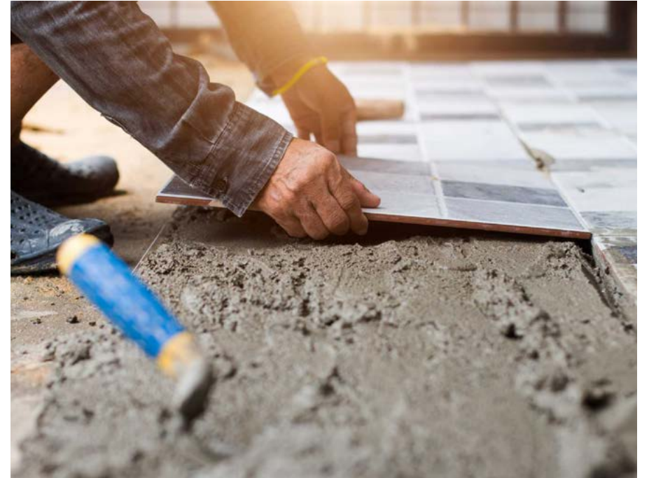
Ongemodificeerde tegellijmen worden aangebracht met de zogenaamde 'dikbed-techniek'
