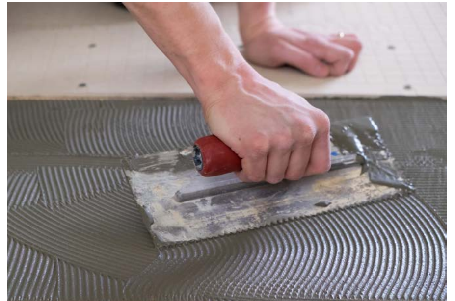
Op geëgaliseerde oppervlakken heeft de dunbedtechniek aanzienlijk minder tegellijm nodig
