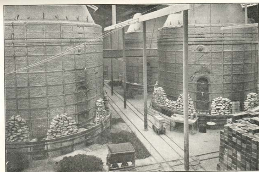
Usine "Carreaux Céramiques" II e division. Hall des fours.
