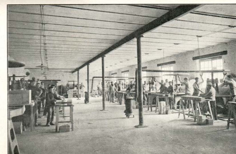
Nouvelle usine "faïence" 4 e division. == Pressage des carreaux de faïence.
