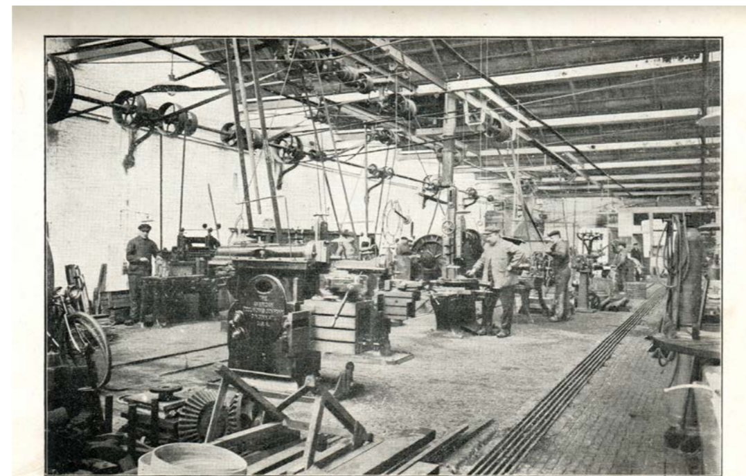
Atelier de Construction et d'entretien. -- Côté des machines-outils.
