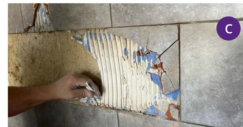
B Examen destructif: retirer une tuile
