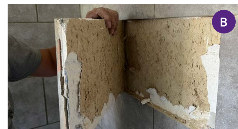
B Examen destructif: retirer une tuile
