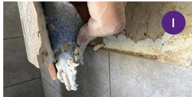
I Vérification de l'adhérence de la membrane d'étanchéité
