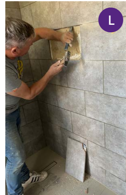
L Retrait d'un carrelage en hauteur
