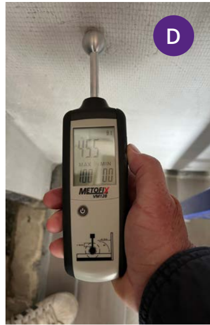
D Mesure d'humidité à hauteur d'yeux. Monte immédiatement à 45% d'humidité.
